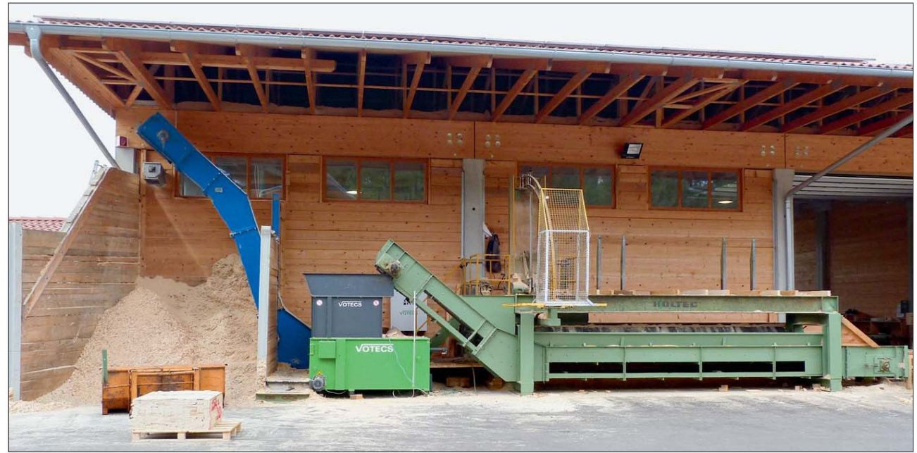
Zu den Produkten von Baumgartner gehören auch Verpackungen und Spezialpaletten. Deren Reste und die Kappreste von der Paketkappsäge werden direkt einem Hacker zugeführt. Ein Querförderer und ein Elevator transportieren die Hackschnitzel direkt zum Zwischenlager (links). Fotos: Ißleib (2); Baumgartner (3), Votecs (1)
